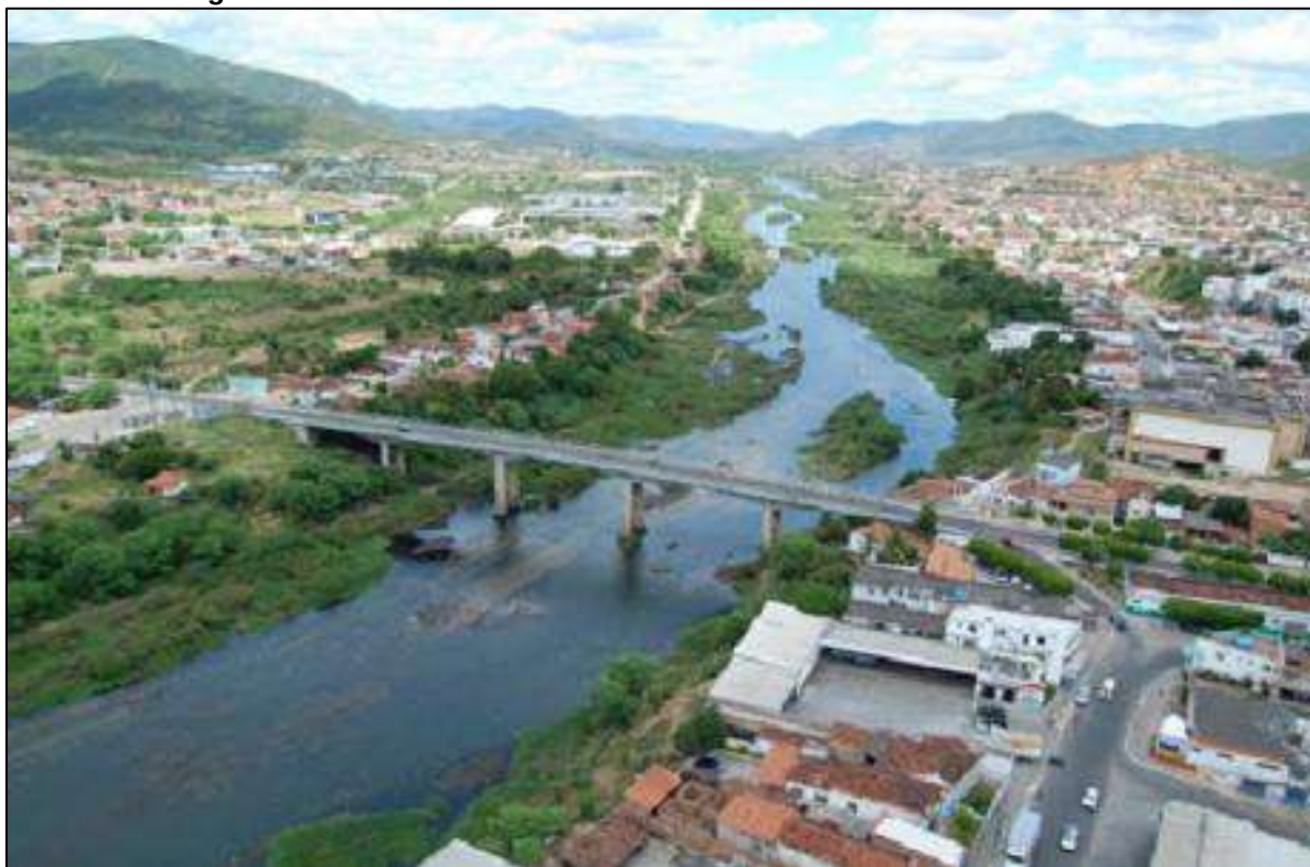
Figura 84 - Vista do trecho urbano da calha fluvial do rio de Contas
