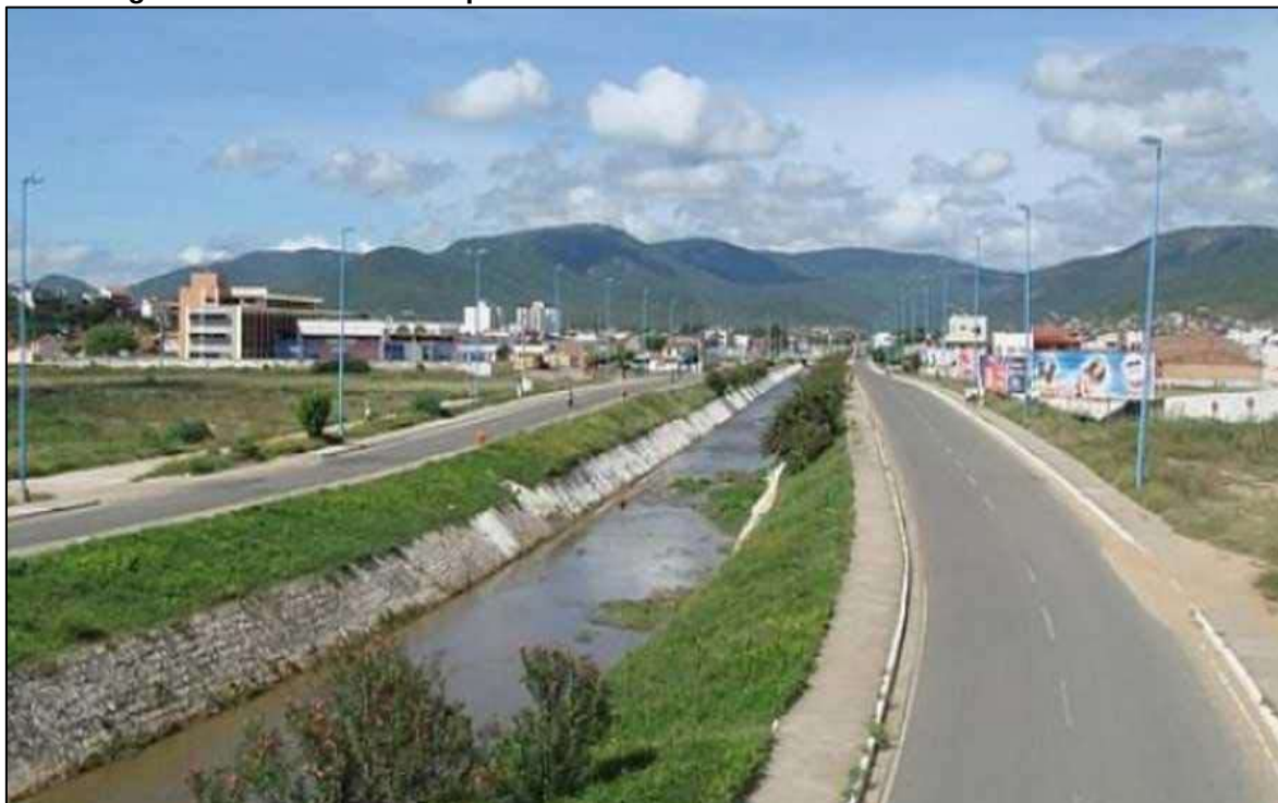
Figura 77 - Vista do rio Jequiezinho em área urbanizada com a calha revestida
