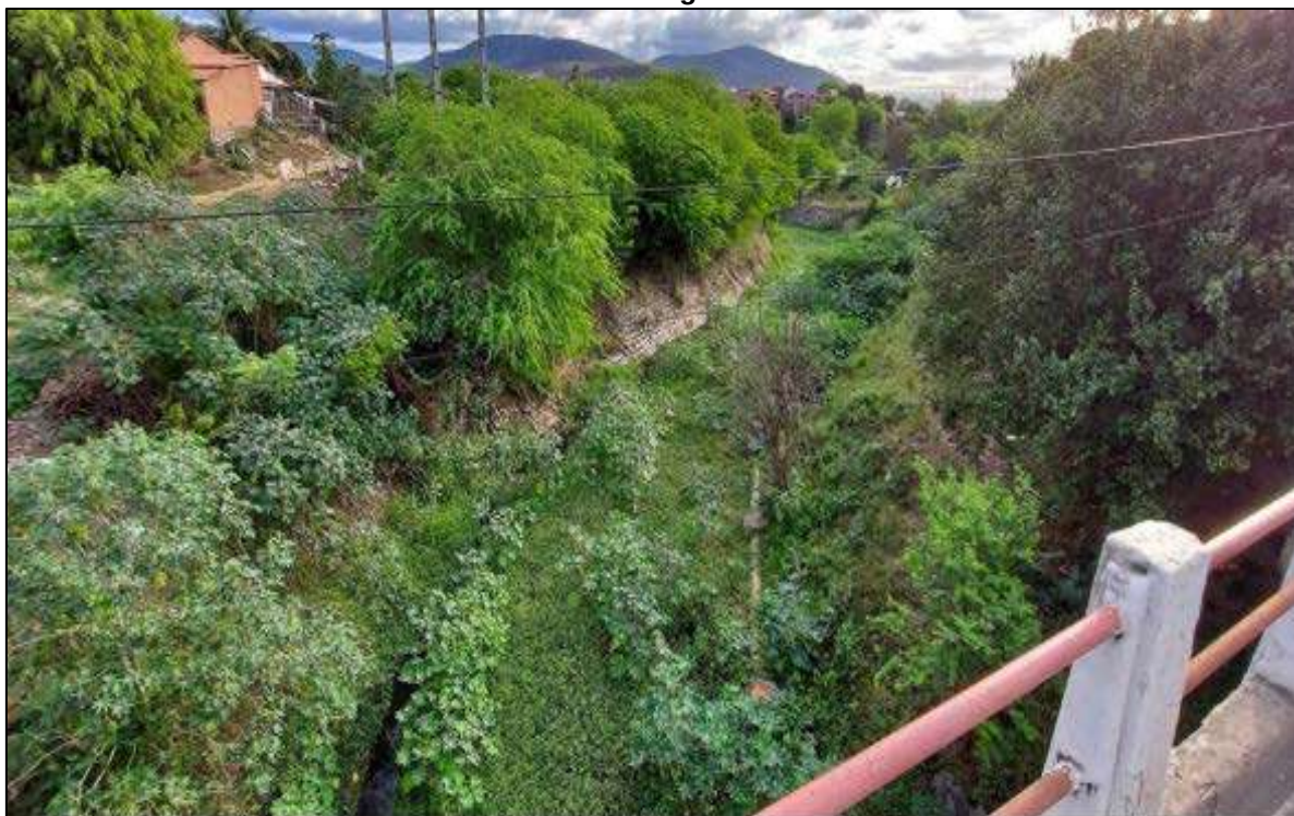
Figura 78 - Vista da calha do rio Jequiezinho na desembocadura no rio das Contas totalmente degradada
