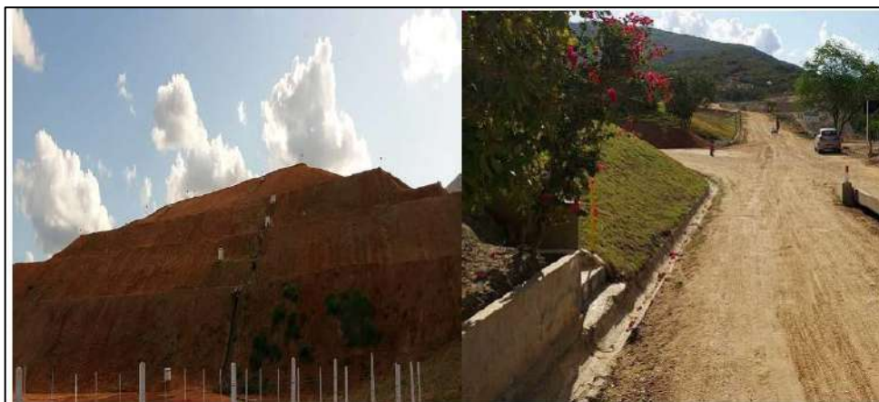
Figura 138 - Sistema de drenagem superficial
