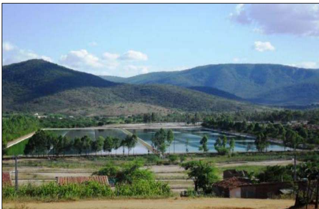
Figura 66 - Vista da Estação de Tratamento de Esgoto de Jequié/BA
