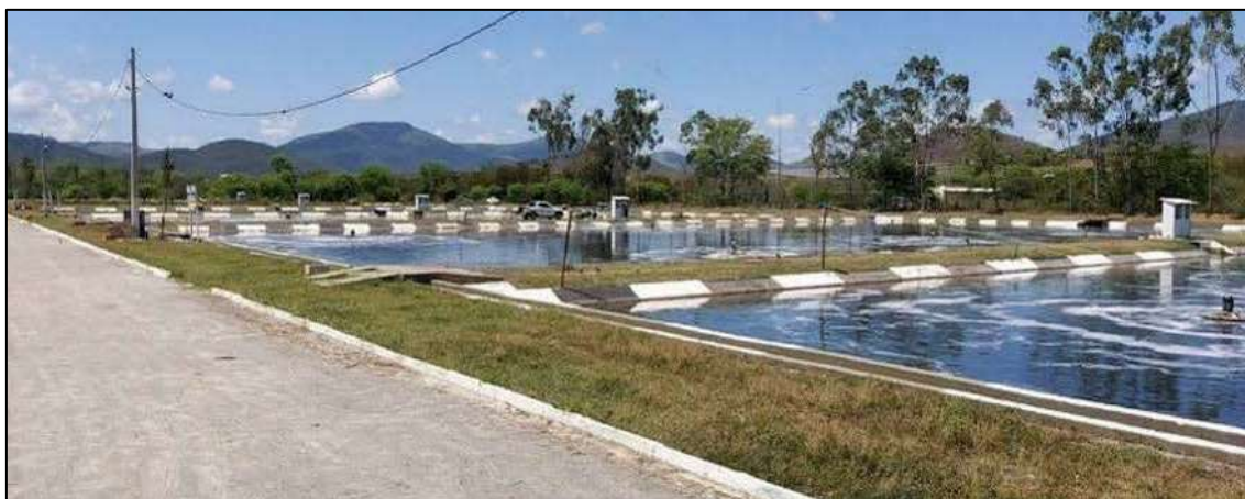
Figura 69 - Lagoas de estabilização – SES Jequié - Sistema de lagoas aeradas em paralelo
