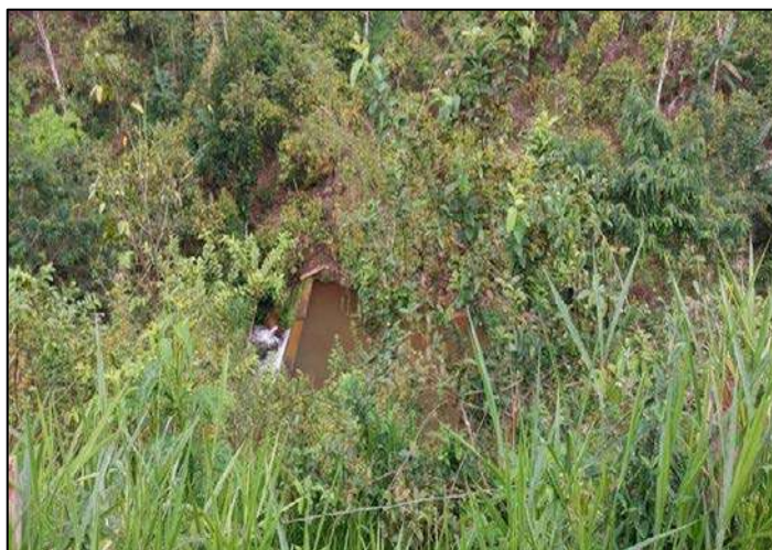
Figura 32 - Captação de água na represa do Rio Atanasio no Distrito de Florestal
