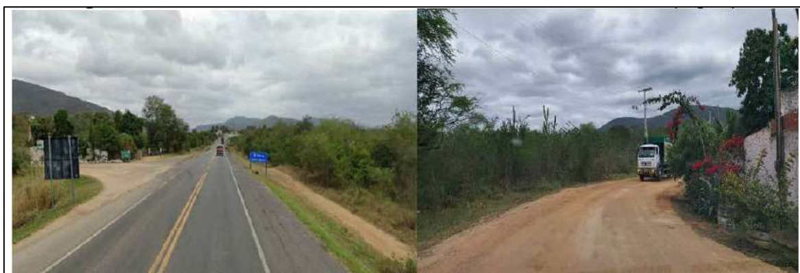
Figura 132 - Estrada de acesso ao Aterro Sanitário Convencional de Jequié/BA
