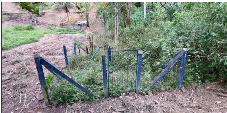
Figura 23 - Captação em poço tubular no Assentamento de Barra Avenida
