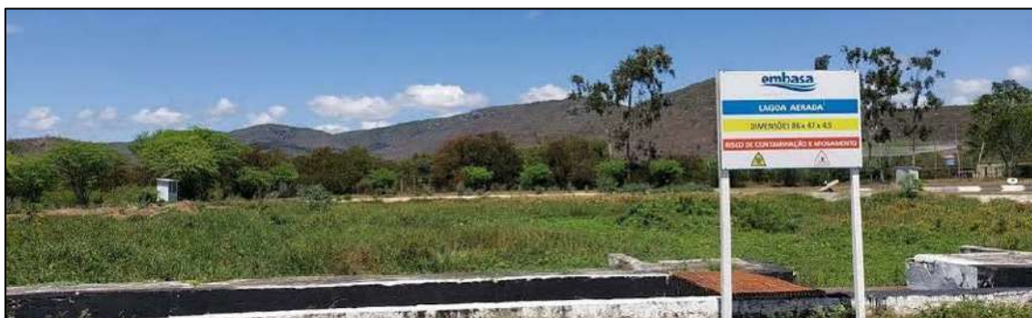
Figura 71 - Lagoas de estabilização – SES Jequié - Lagoa aerada desativada
