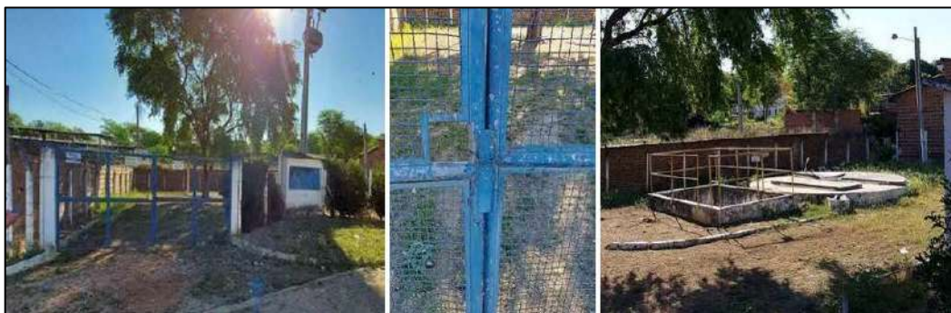
Figura 51 - Estação Elevatória de Esgoto 03
