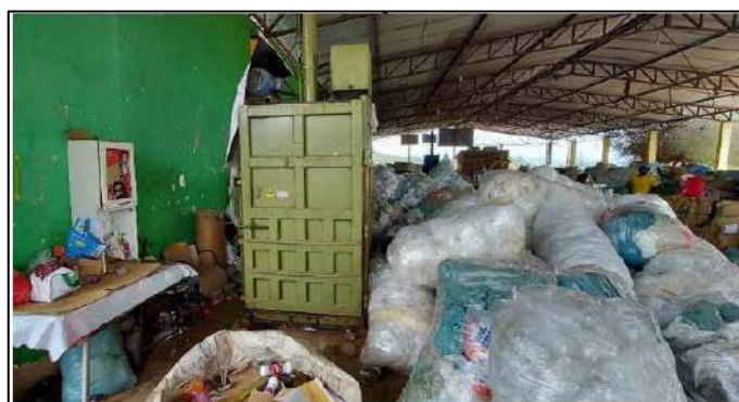
Figura 126 - Vista do galpão onde ficam armazenados os equipamentos e os materiais recicláveis prensados
