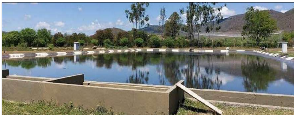
Figura 70 - Lagoas de estabilização – SES Jequié - Lagoa de decantação
