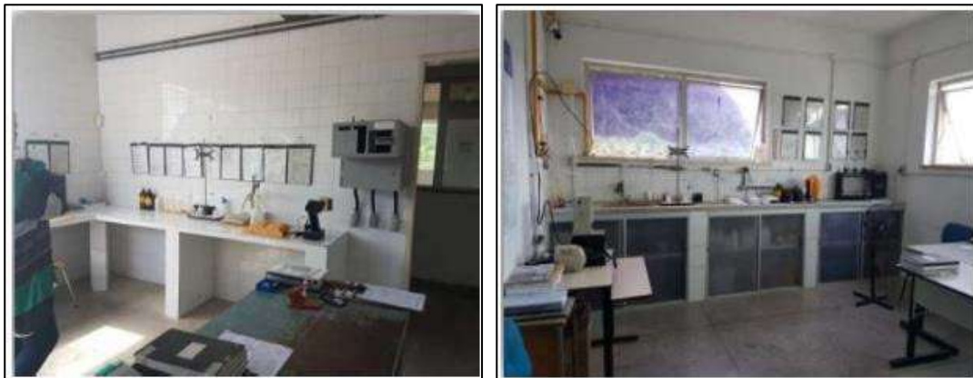
Figura 9 - Laboratório da ETA de Criciúma (esquerda) e ETA da Pedra (direita)
