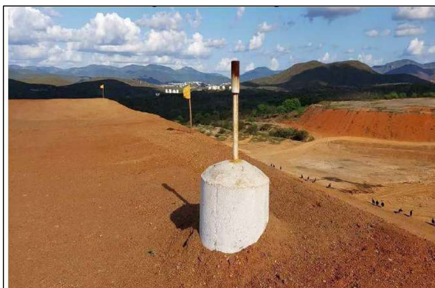
Figura 139 - Dreno de gases
