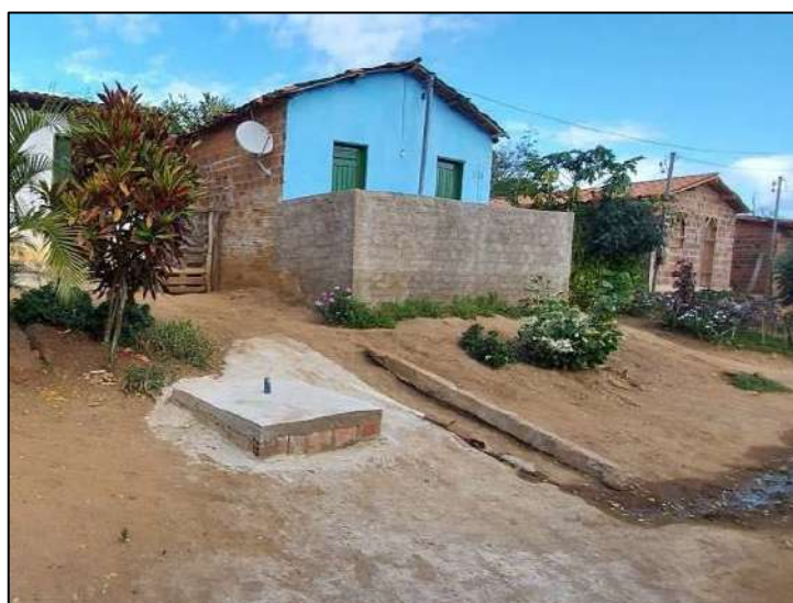
Figura 84 - Destinação de esgotos domésticos no Distrito de Baixão
