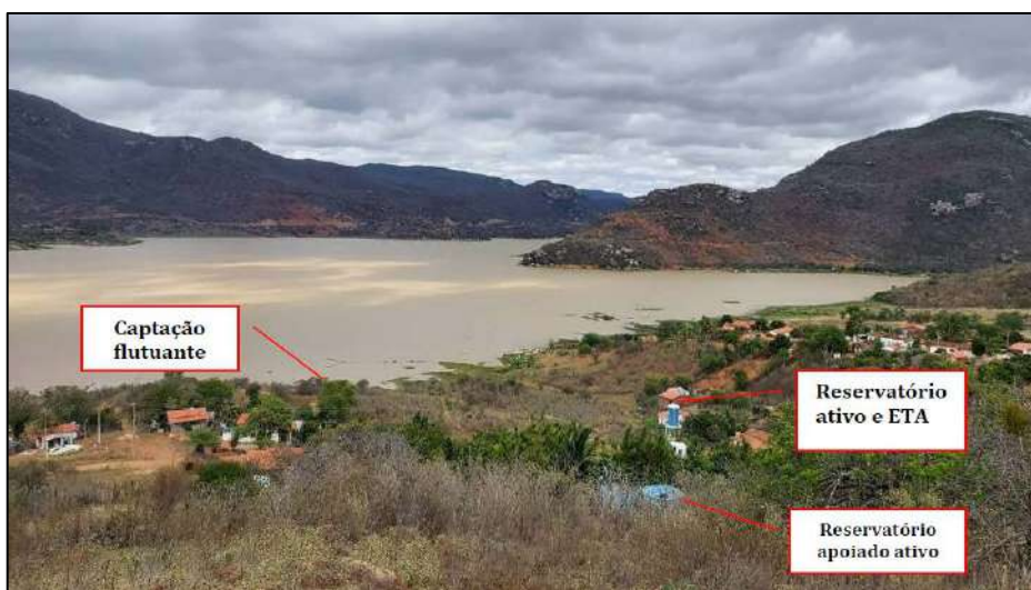
Figura 22 - Vista geral do SSAA de Monte Branco
