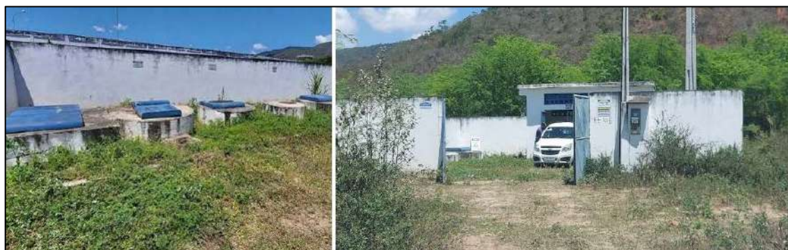
Figura 65 - Estação Elevatória de Esgoto 10B
