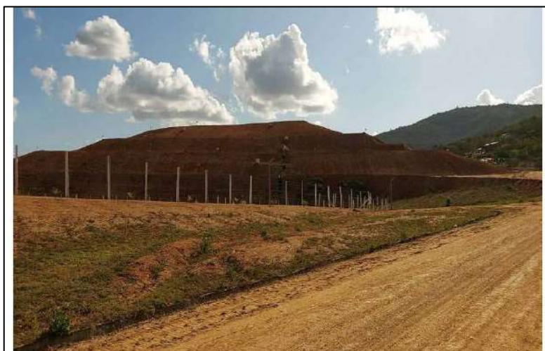
Figura 134 - Unidade celular utilizada para a disposição dos resíduos
