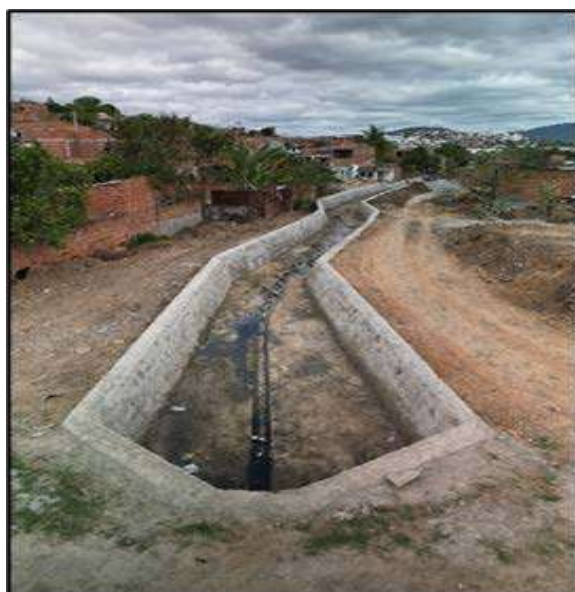
Figura 94 - Canal de macrodrenagem Sunville/Pompílio Sampaio
