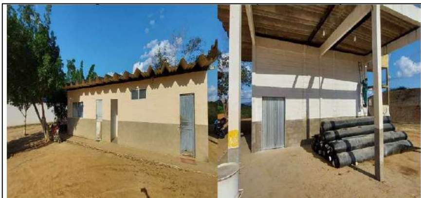
Figura 142 - Edifícios de administração e de manutenção
