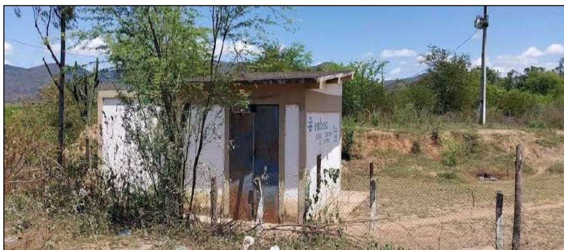
Figura 63 - Estação Elevatória de Esgoto 10
