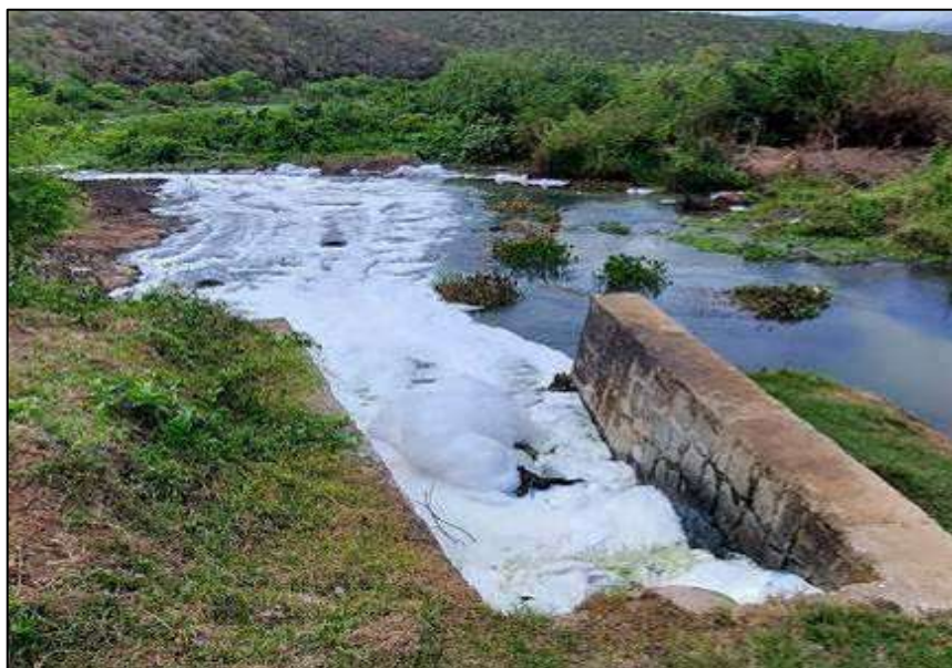
Figura 74 - Ponto de lançamento do esgoto tratado do SES Jequié
