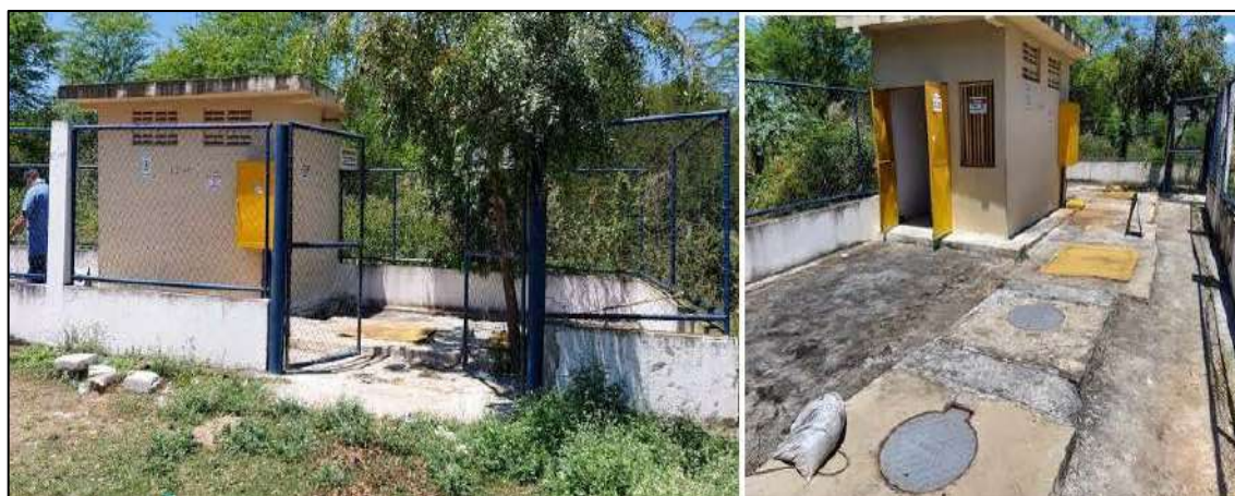
Figura 64 - Estação Elevatória de Esgoto 10A
