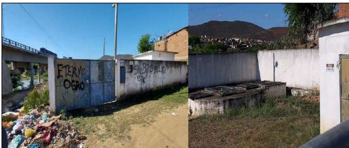
Figura 57 - Estação Elevatória de Esgoto 06
