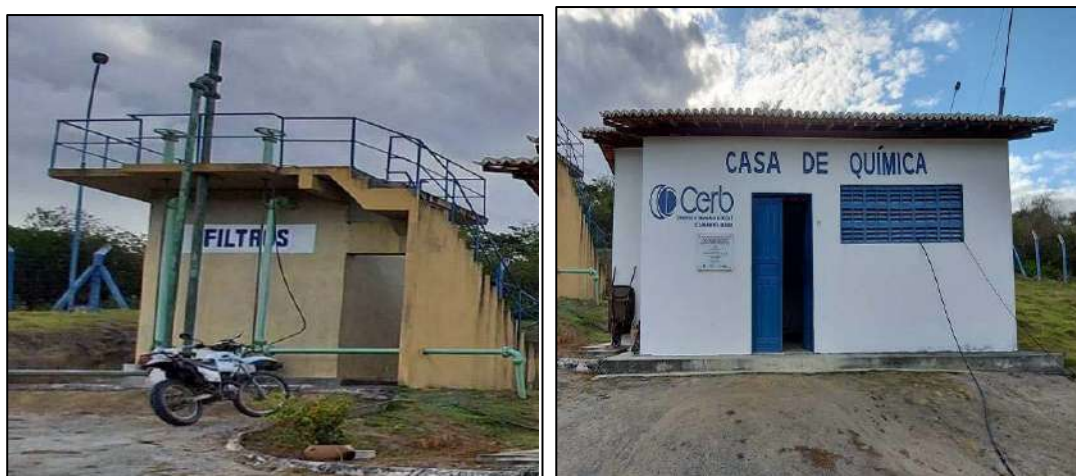
Figura 28 - Filtros de fluxo ascendente e casa de química
