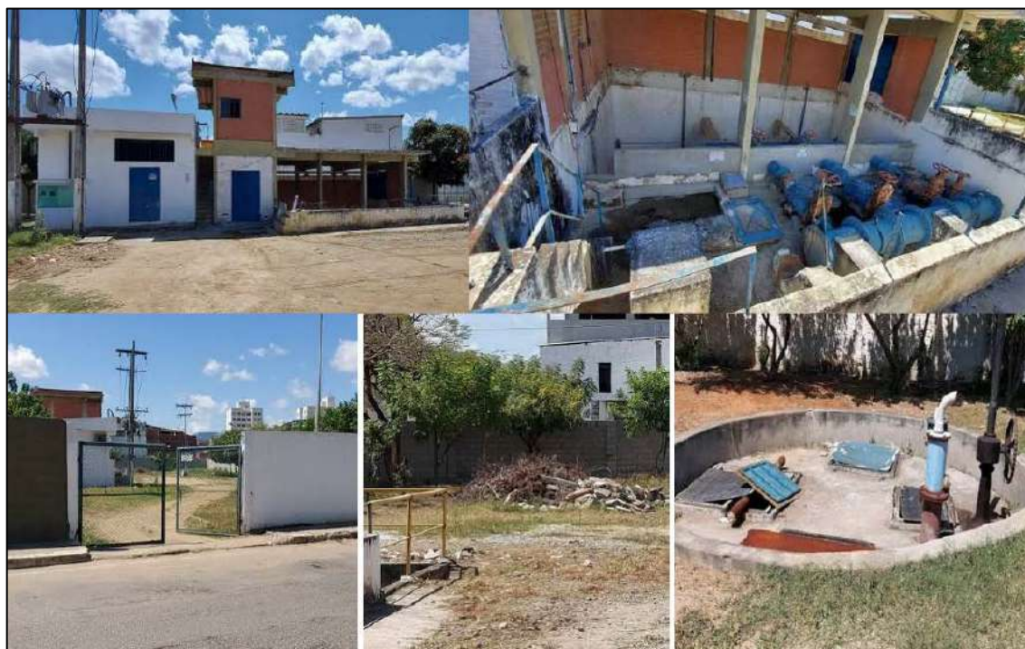
Figura 50 - Estação Elevatória de Esgoto 02
