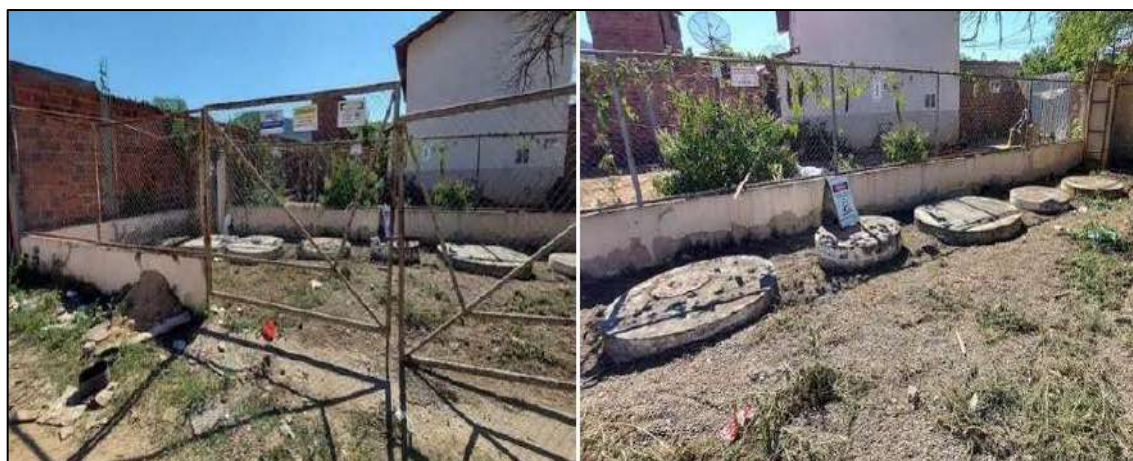
Figura 61 - Estação Elevatória de Esgoto 09A
