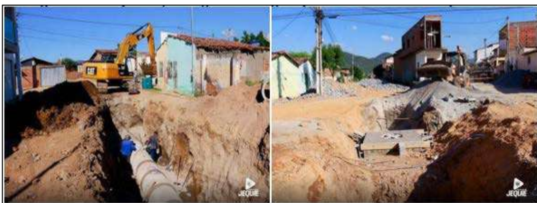
Figura 93 - Implantação de galeria de águas pluviais na rua Dr. Ivan José da Silva
