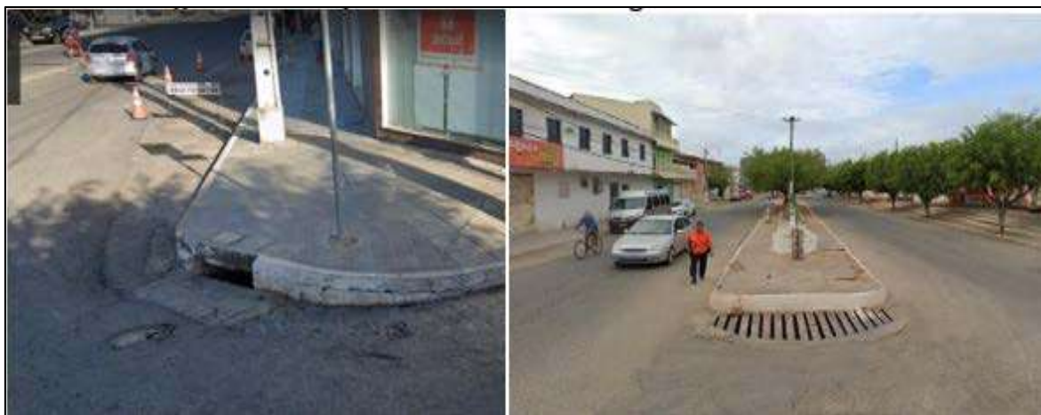
Figura 90 - Dispositivos de microdrenagem na Av. Santa Luzia
