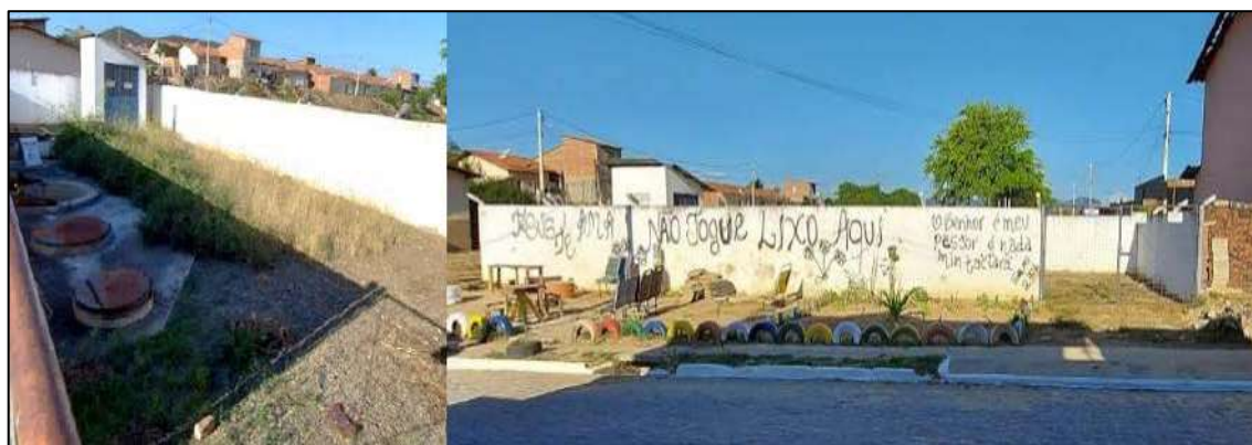
Figura 55 - Estação Elevatória de Esgoto 04C
