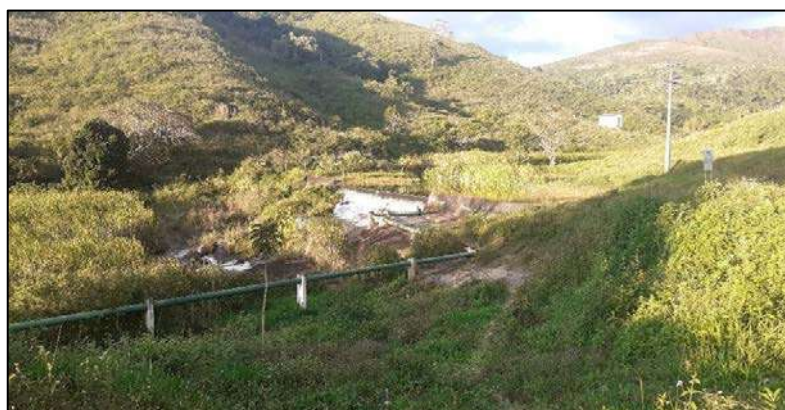
Figura 36 - Captação de água bruta no Rio dos Vieiras
