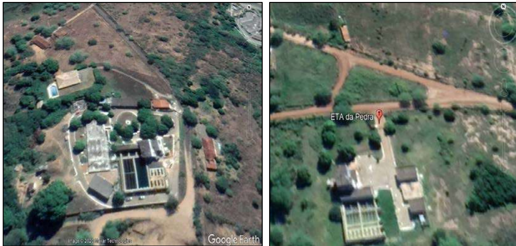
Figura 10 - Visão geral das infraestruturas da ETA Criciúma
