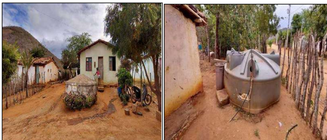
Figura 38 - Cisternas de alvenaria e de polietileno na localidade de Nova Esperança
