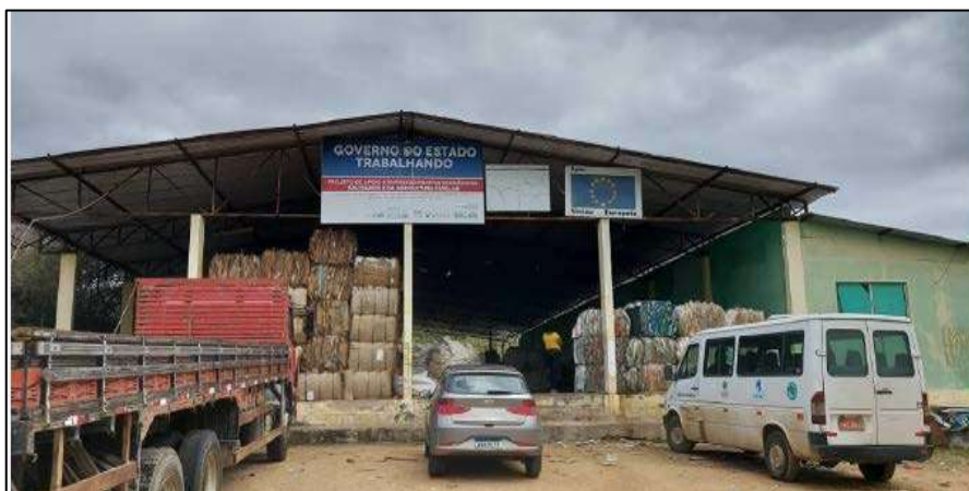
Figura 124 - Sede da Cooperativa de Catadores Recicla Jequié
