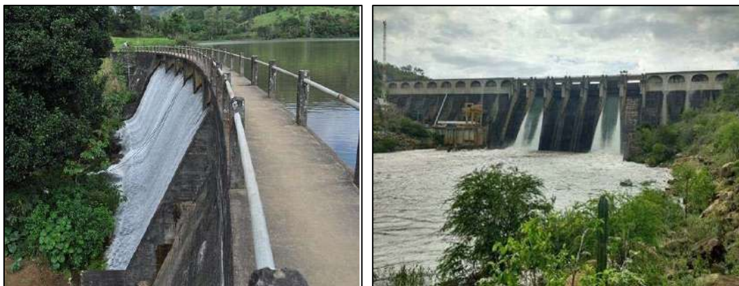
Figura 6 - Barragens que atendem o SAA de Jequié. Esquerda barragem de Criciúma e direita barragem da Pedra
